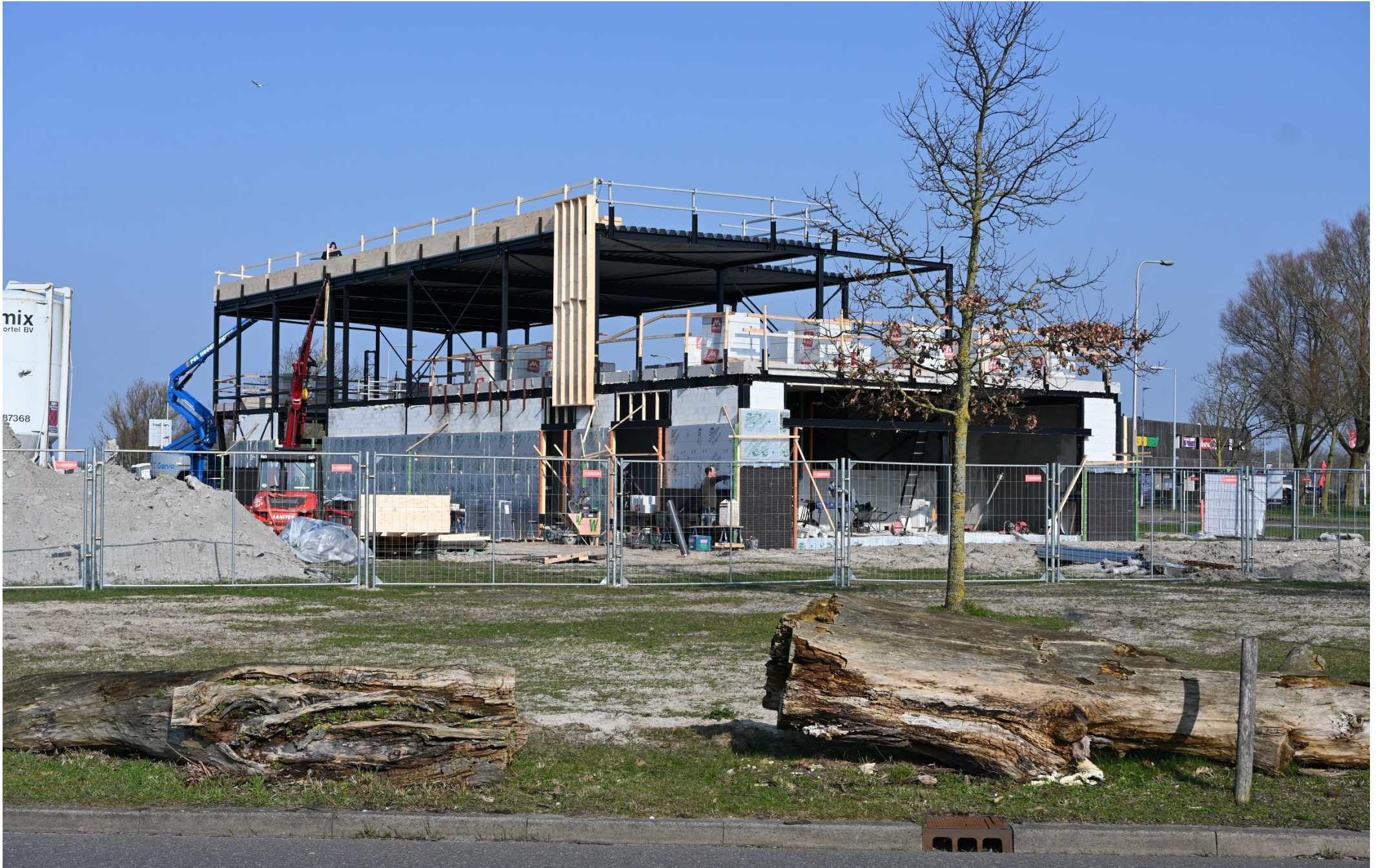
Bouwwerkzaamheden op kavel A
