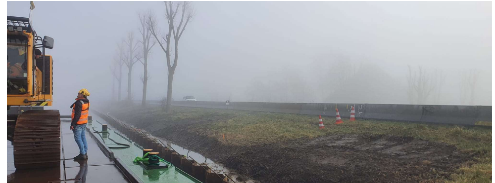
Werkzaamheden aan de oostkade van het Kanaal
