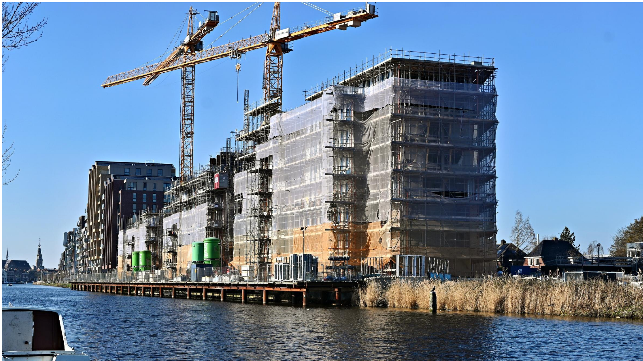
Woningbouw fase 1B Jaagpad Oost
