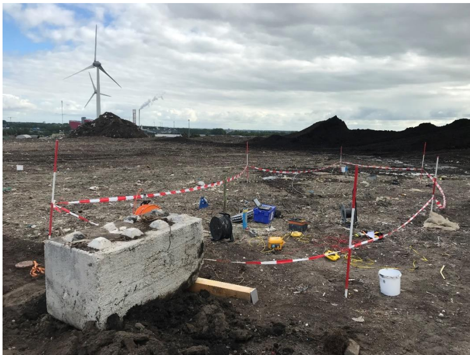
Foto 2.1: Foto van de uitvoering down hole seismisch onderzoek Sortiva, Alkmaar.
