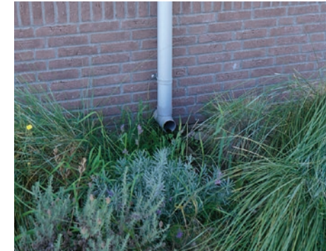
Voorbeeld van zichtbaar afkoppelen van de hemelwaterafvoer.
