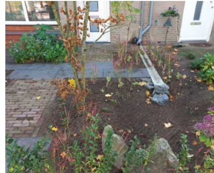
Voorbeeld van zichtbaar afkoppelen van de hemelwaterafvoer.
