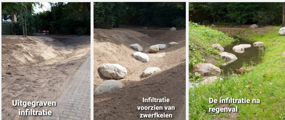
Figuur 2.4: Werkzaamheden van de wadi
