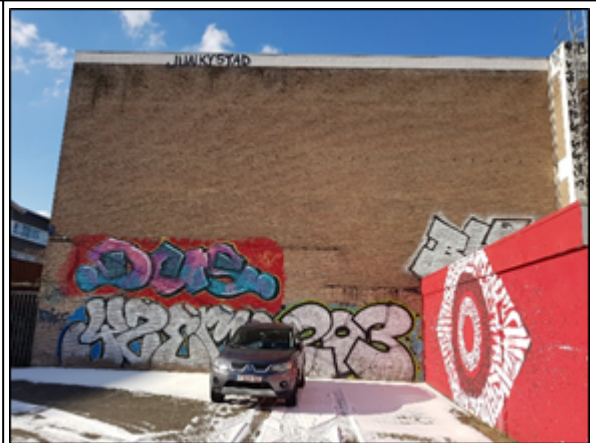
Inmiddels gesloopt gebouw zuidzijde vanuit binnenplein.
