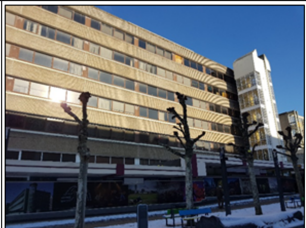
Inmiddels gesloopt gebouw zuidzijde plangebied.
