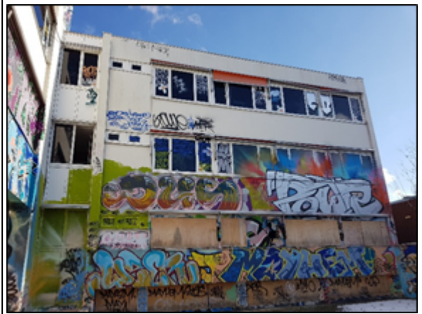
Inmiddels gesloopt gebouw noordzijde vanuit binnenplein.
