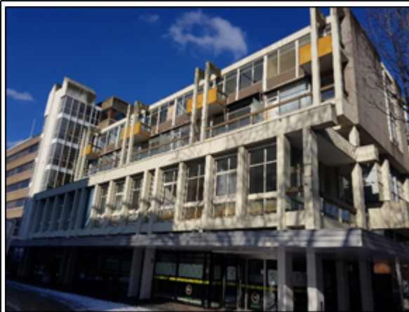
Te renoveren gebouw oosthoek plangebied (het voormalige Rabobankgebouw, aansluitend aan het plangebied).
