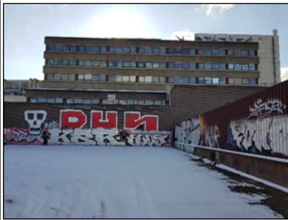
Inmiddels gesloopte gebouwen zuidzijde vanuit binnenplein.
