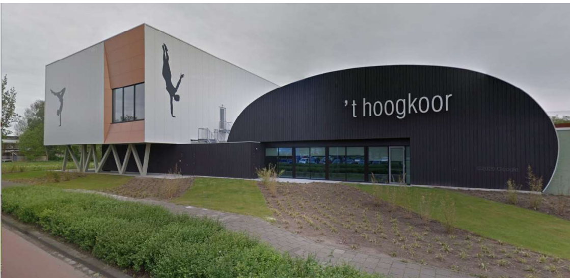
Figuur 4.16: sportcomplex 't Hoogkoor aan de Burgemeester Verkuijlstraat (Bron: Google Maps, 2019)
