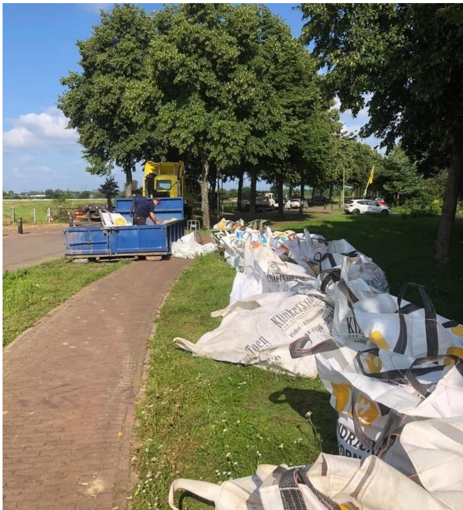
De aanleg van de nooddijk in Leudal. Bron: dhr. R. Martens
