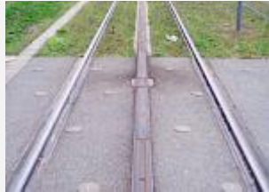
De derde rail
