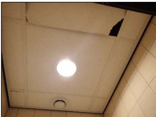
Beschadiging systeemplafond
