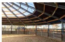
- REFERENTIE FOTO BINNENZIJDE DAKCONSTRUCTIE - "stap-lougerie"
