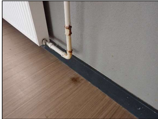
Corrosie leidingwerk
