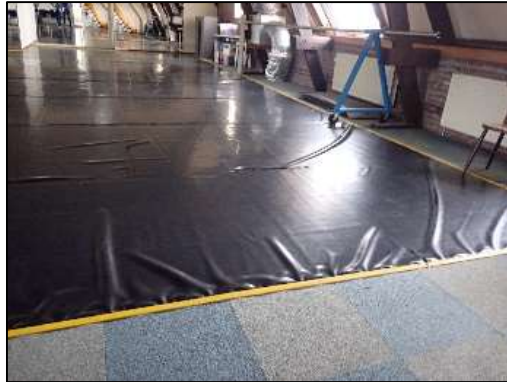
Plooiende c.q. losse afdekking tapijt t.b.v. gebruik als danszaal
