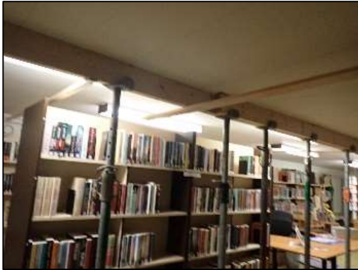
Stutten t.p.v. souterrain
