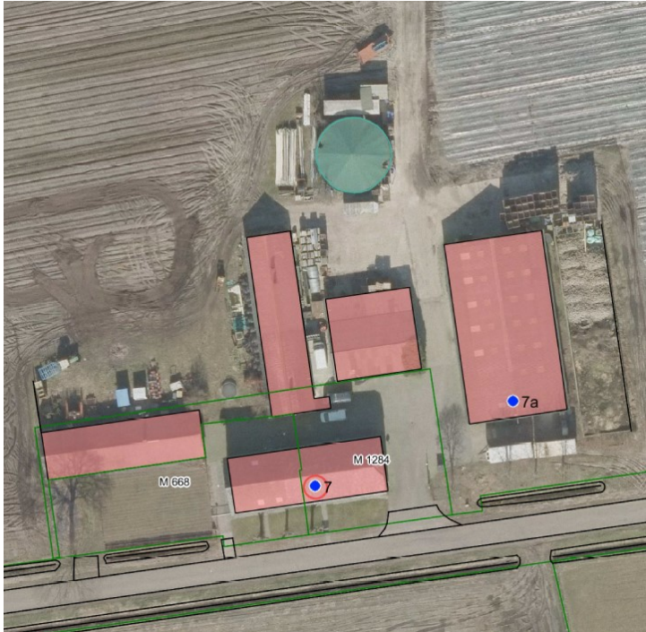
Luchtfoto huidige situatie
