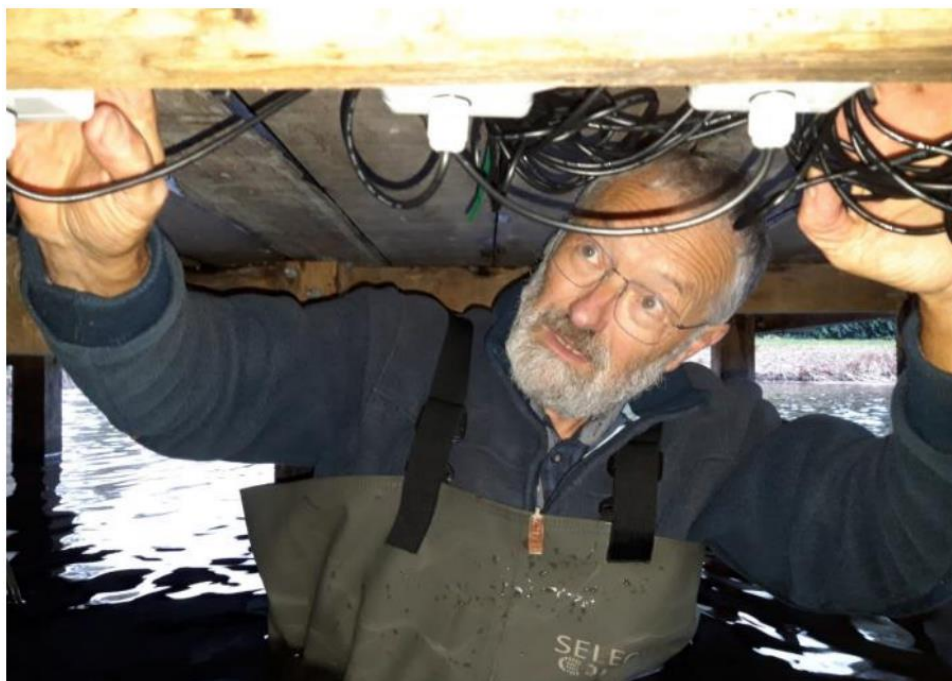
Een vrijwilliger van SOEN inspecteert de warmtewisselaar in de vijver
