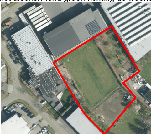
Luchtfoto bestaand (zonder afschermend groen t.h.v. noordelijk gelegen bebouwing)
