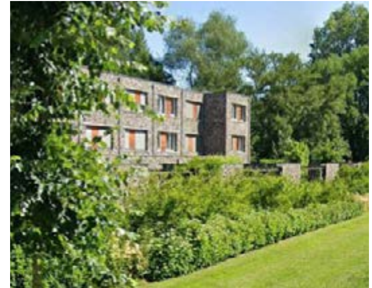
groene overgang naar het park
