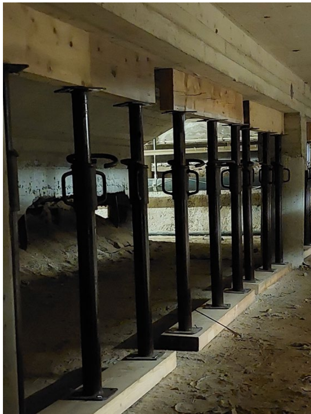
Figuur 4.2: De gestutte constructie
