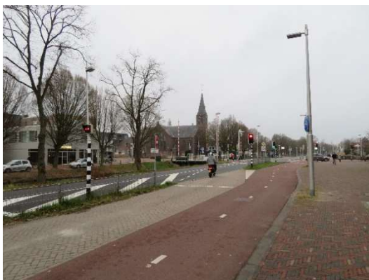
Foto 1 Roodlichtnegatie door een bromfiets op de Rijksstraatweg
