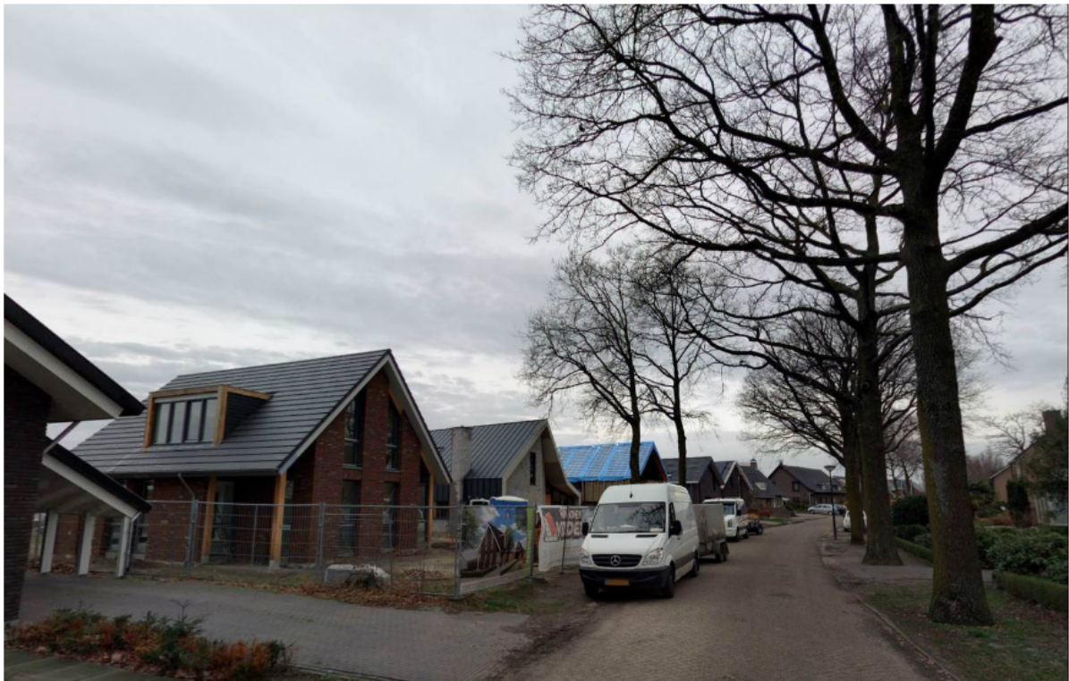
Foto 2/ maart 2019 van de bebouwde gemeentelijke kavels. Gefotografeerd vanuit zuidelijke deel Schepersweg.
