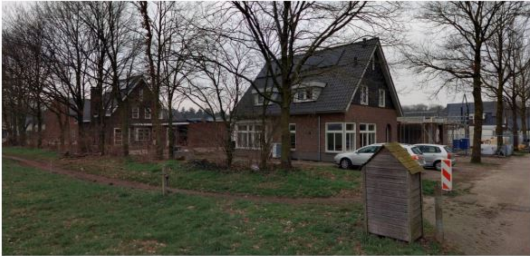
Foto 3/ 8 maart 2021 van het in aanbouw zijnde deelgebied 3. Gefotografeerd vanuit hoek Spechtenlaan / einde plangebied.
