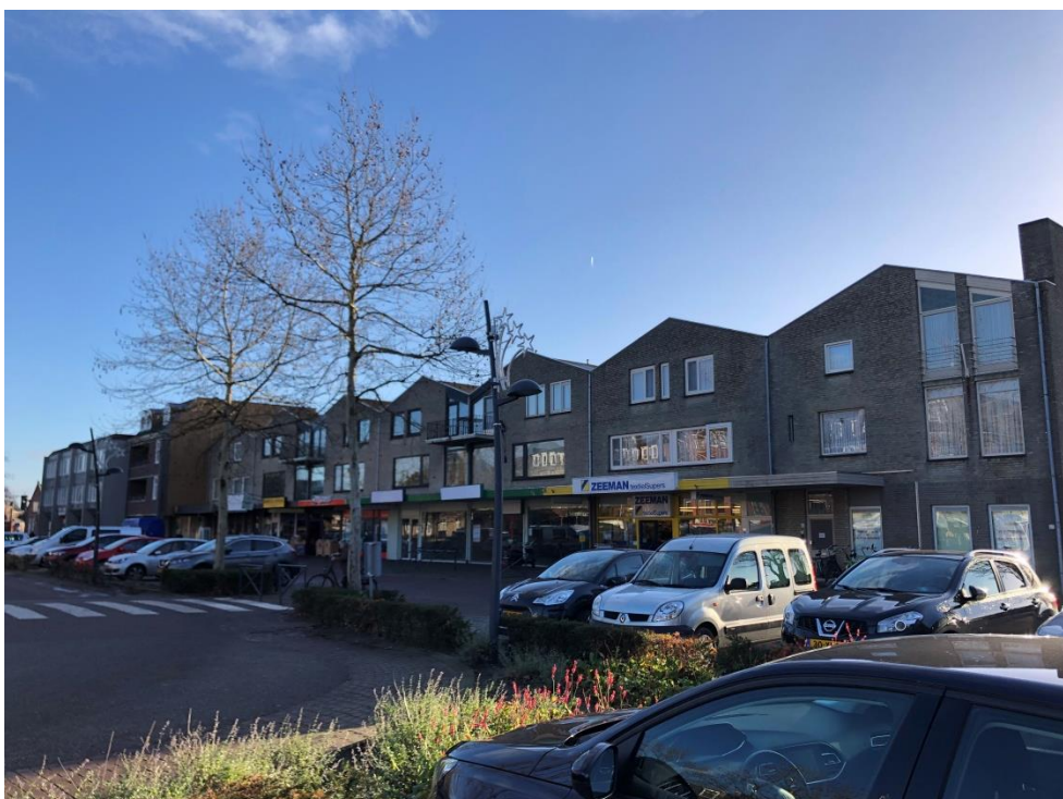
Huidige bebouwing Zuidwand Sint Agathaplein (foto: NieuwBlauw, 2018)
