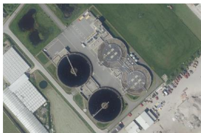
Figuur 4 - luchtfoto AWZI Noordwijk
