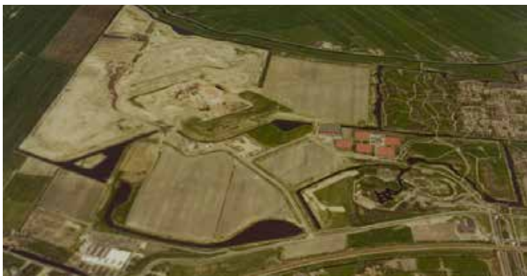
Luchtfoto van het Buytenpark, gedeeltelijk nog in aanleg. Onderaan het wit beschilderde dak van tuincentrum Intratuin aan de Voorweg. Linksboven de puinstort, waarmee een kunstmatig heuvellandschap wordt gecreëerd, 1/7/1993, SA TH0000007517
