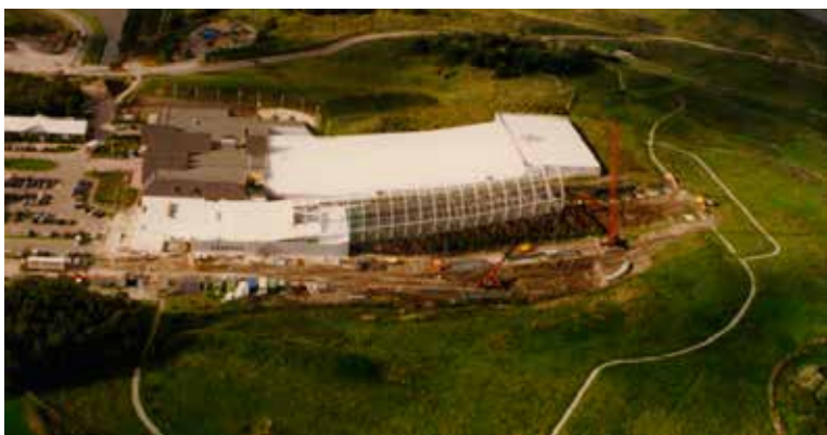
Luchtfoto van de bouw van Snow World in het Buytenpark, 1/11/2001, SA TH0000007941
