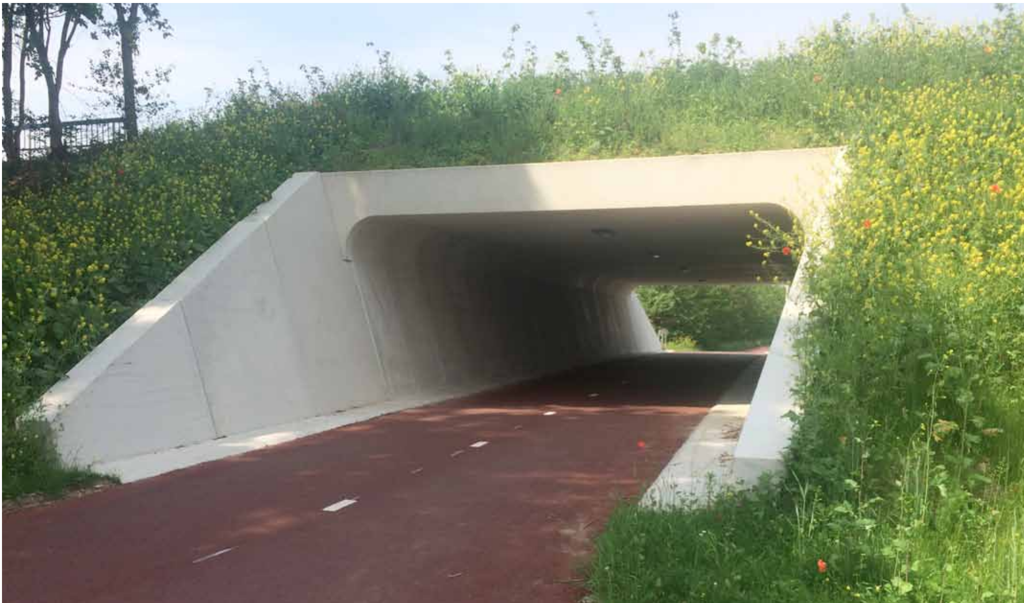
Referentie wandafwerking en overgang wand-plafond: de fietstunnel onder de Bemmelseweg in de F325 (verlichting niet representatief)
