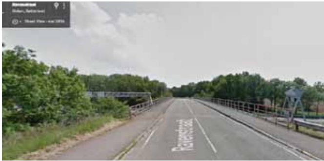
Ravenstraat (Zevenaar) -> nieuw viaduct
