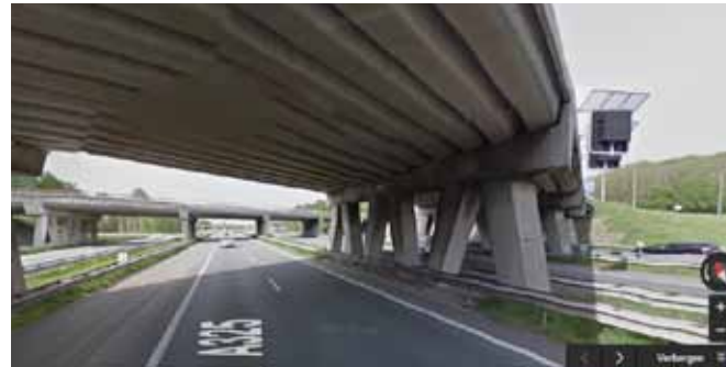
Nieuw viaduct in de A15, over de A325 Arnhem-Nijmegen -> zelfde doorgangsprofiel en positie tussensteunpunten, nauw verwante architectonische vormgeving
