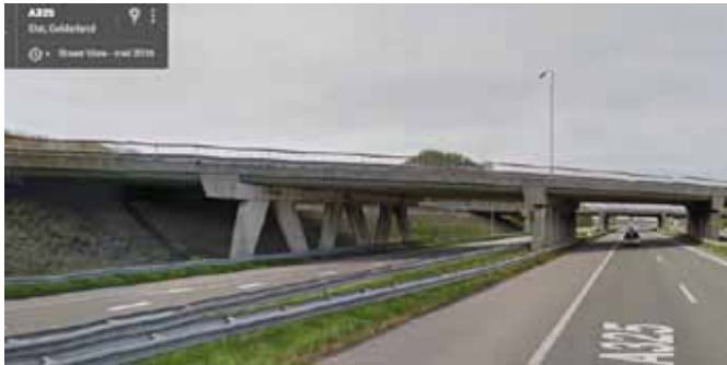
Nieuw viaduct in de A15, over de A325 Arnhem-Nijmegen -> zelfde doorgangsprofiel en positie tussensteunpunten, nauw verwante architectonische vormgeving
