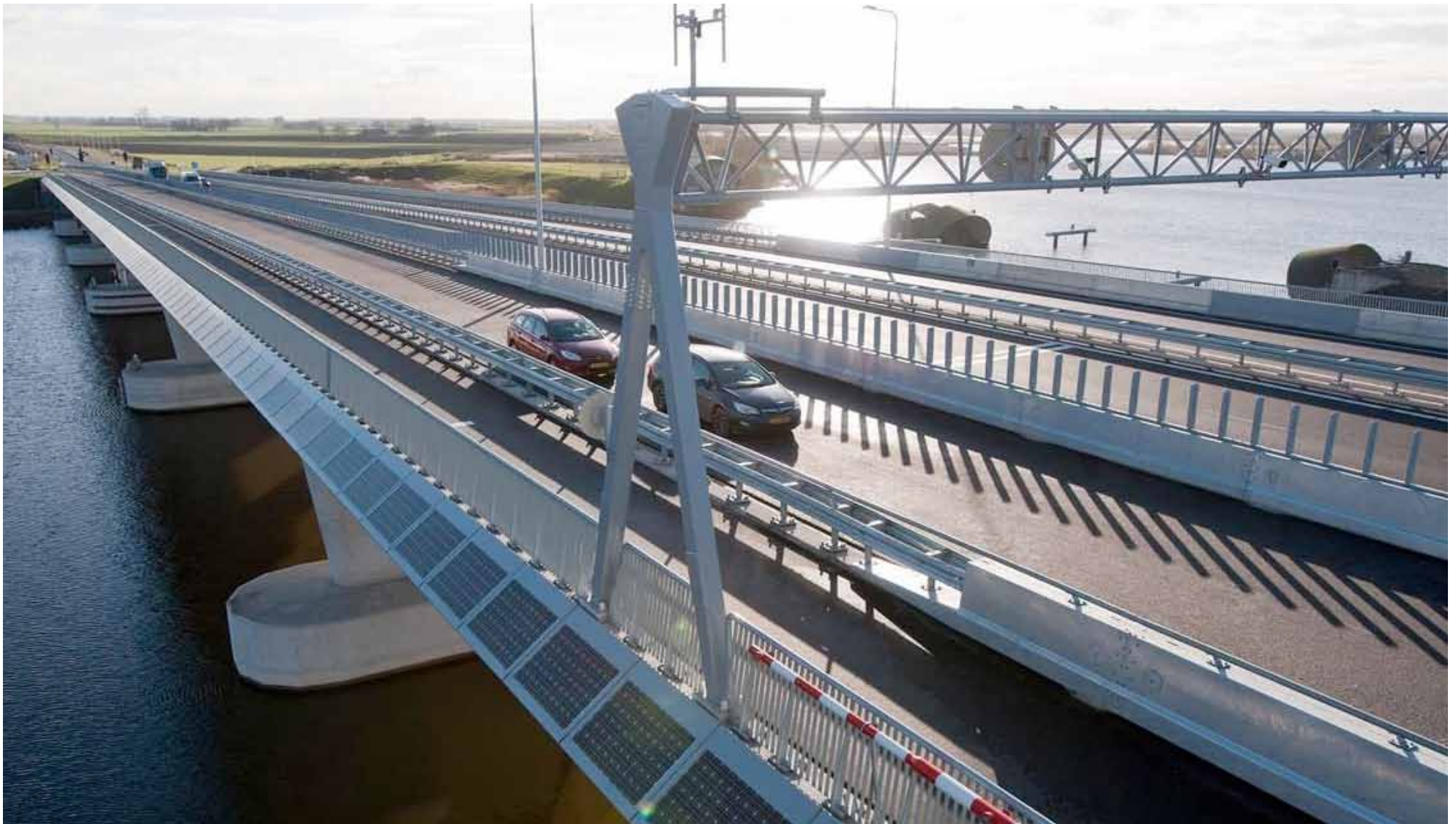
De Ramspolbrug in de N50 bij Zwolle, waarin monokristallijne zonnepanelen integraal deel uitmaken van de randafwerking. (bron: rtvoost.nl)
