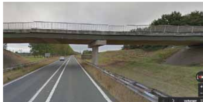
Viaduct over de A15 in De Plak (aan weerszijden verbreed of geheel vervangen) -> zelfde doorgangsprofiel en positie tussensteunpunten, architectonische vormgeving van de verbredingen conform eisen 'nieuw viaduct A15'
