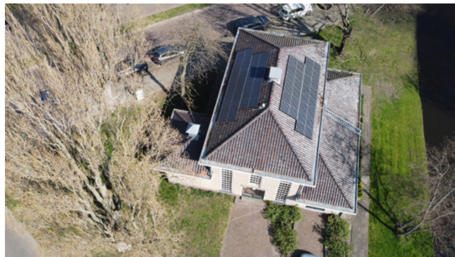
Zonnepanelen op dak van gemaal Kempersingel
