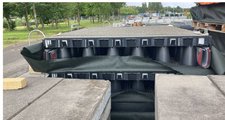
Plastic Road: holle ruimtes in de weg vangen hemelwater op
