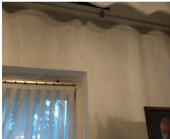
Geen scheuren aan de binnenkant boven
