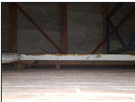
Afbeelding 4: Ruimtes onder isolatiepanelen
