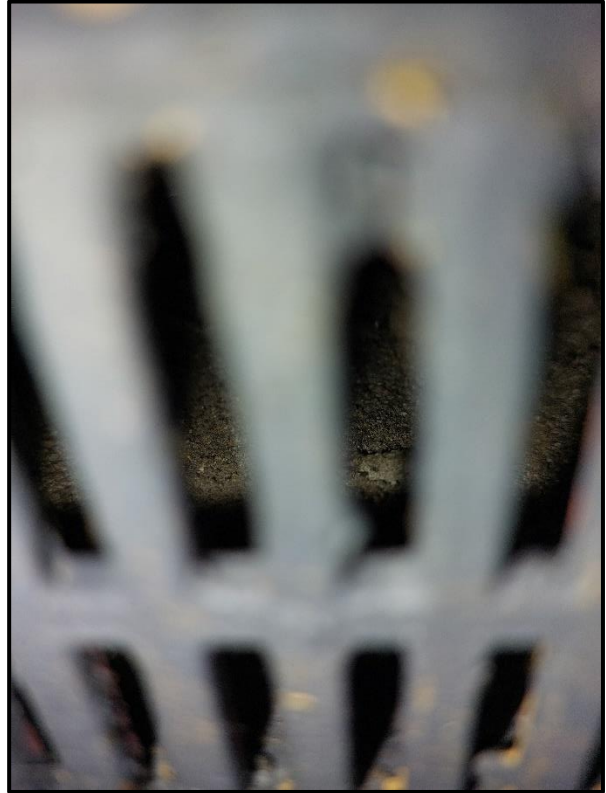
Figuur 2.4 Links: weergave dilatatievoeg. Rechts: weergave van de situatie van de spouw achter een bijenbekje. Zichtbaar is dat de spouw niet is opgevuld.
