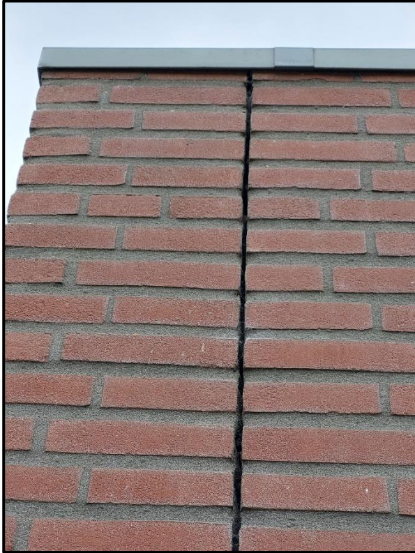
Figuur 2.4 Links: weergave dilatatievoeg. Rechts: weergave van de situatie van de spouw achter een bijenbekje. Zichtbaar is dat de spouw niet is opgevuld.
