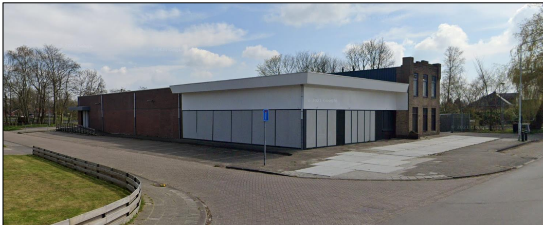
Figuur 2.2 Aanzicht op de projectlocatie
