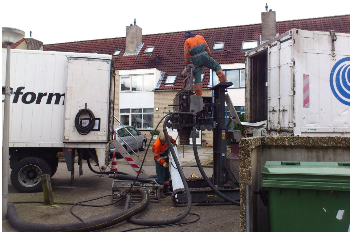
Figuur 5: Rioolrenovatie door relinen
