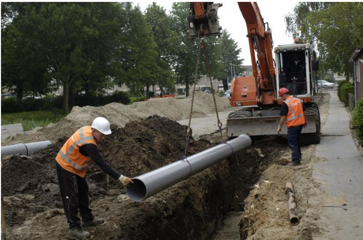
Figuur 9: Vervangen vrijvervalriolering
