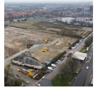
Merwedekanaalzone: Faciliterend grondbeleid
