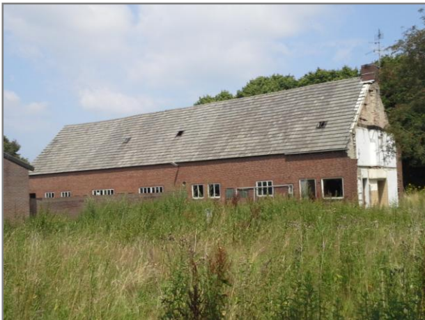
Foto 15: boerderij met rechts de gesloopte woning
