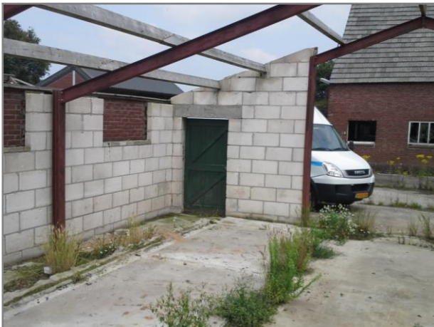
Foto 9: voormalige standplaats bovengrondse dieseltank (in hoek van de opslagschuur)
