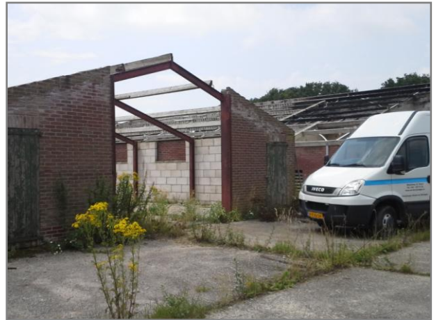
Foto 8: erf met (opslag)schuur waarin de bovengrondse dieseltank heeft gestaan
