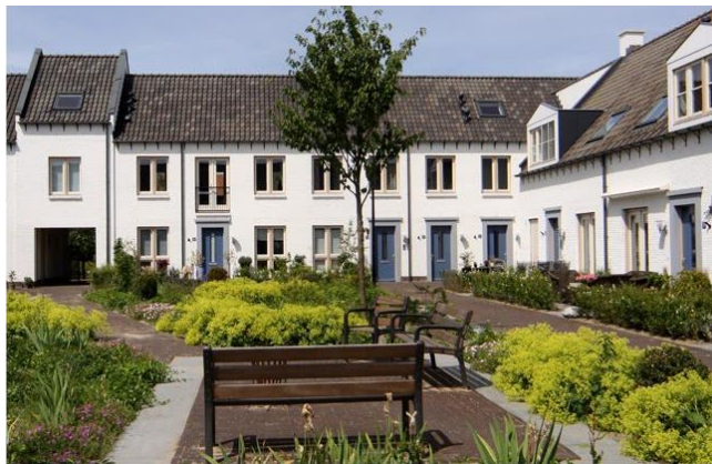
Referentie: appartementengebouw aan groen hof
