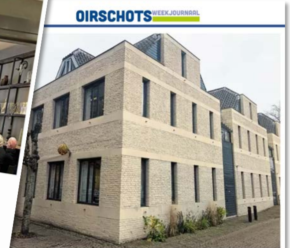
neentehuis; duidelijk herkenbaar de stijl van de Bossche School
