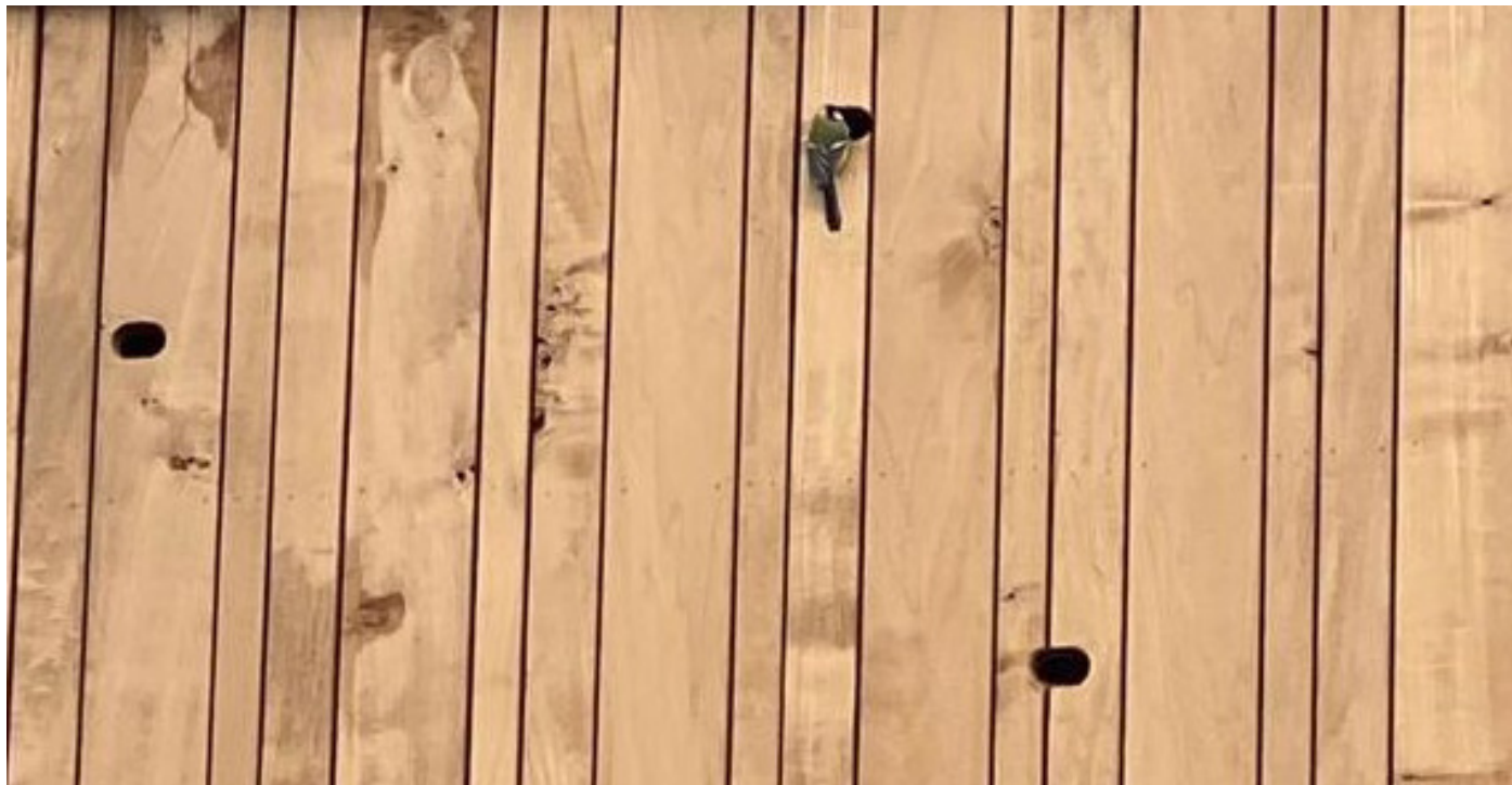
Nestkasten achter gevelbekleding
