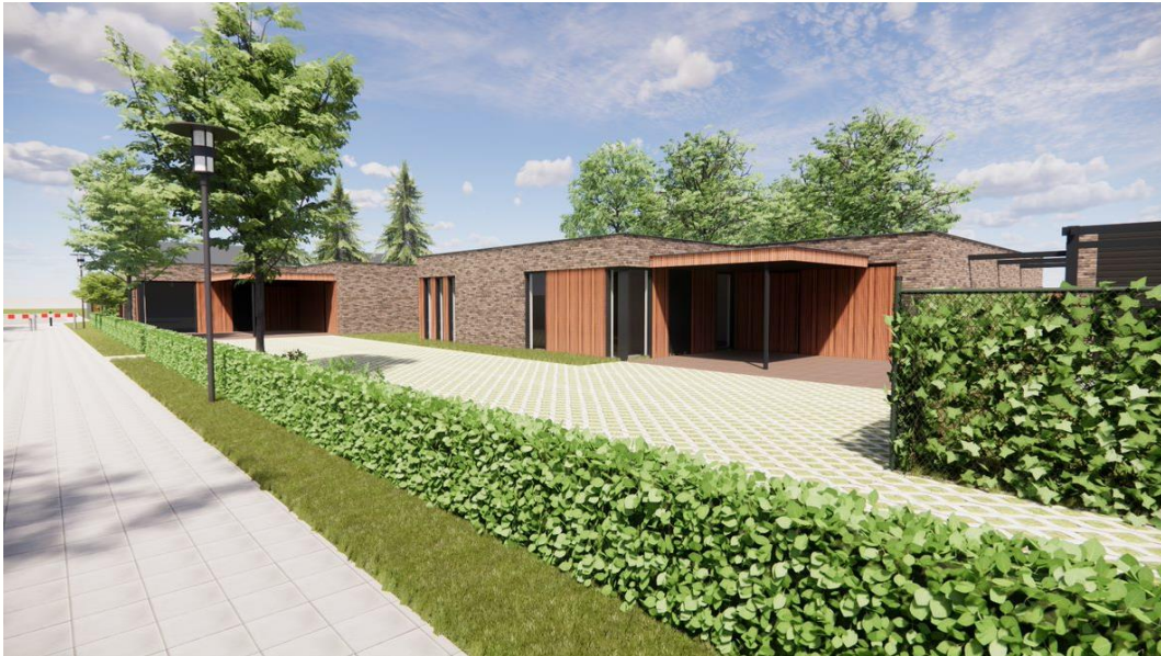
Figuur 11: woningen gesitueerd aan een erf, gezien vanaf het voet-/fietspad
