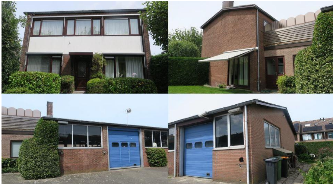
Huidig plangebied; op de planlocatie is men voornemens om de bedrijfshal (foto's onder) te slopen. De huidige woning (foto's boven) blijft behouden (bron: Blom Ecologie)
