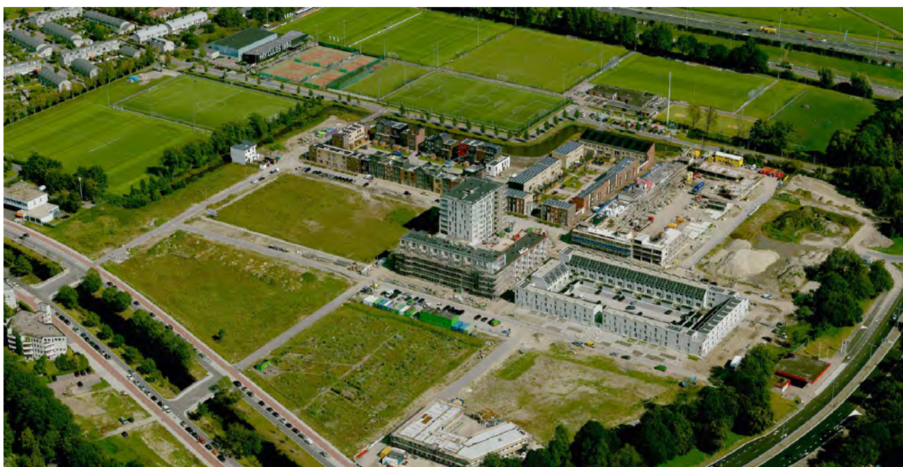
Figuur In aanbouw zijnde woningbouwlocatie:
