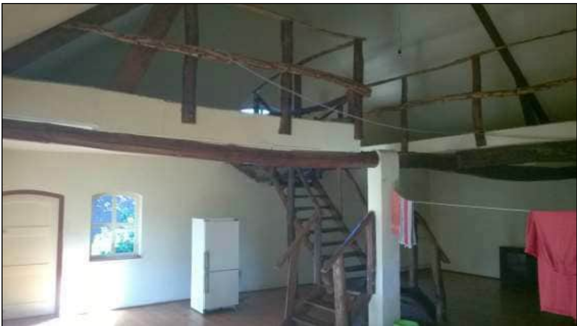
Zicht op de in het achterste deel van de schuur gerealiseerde vide, met een trap en balustrade van hergebruikt hout.
