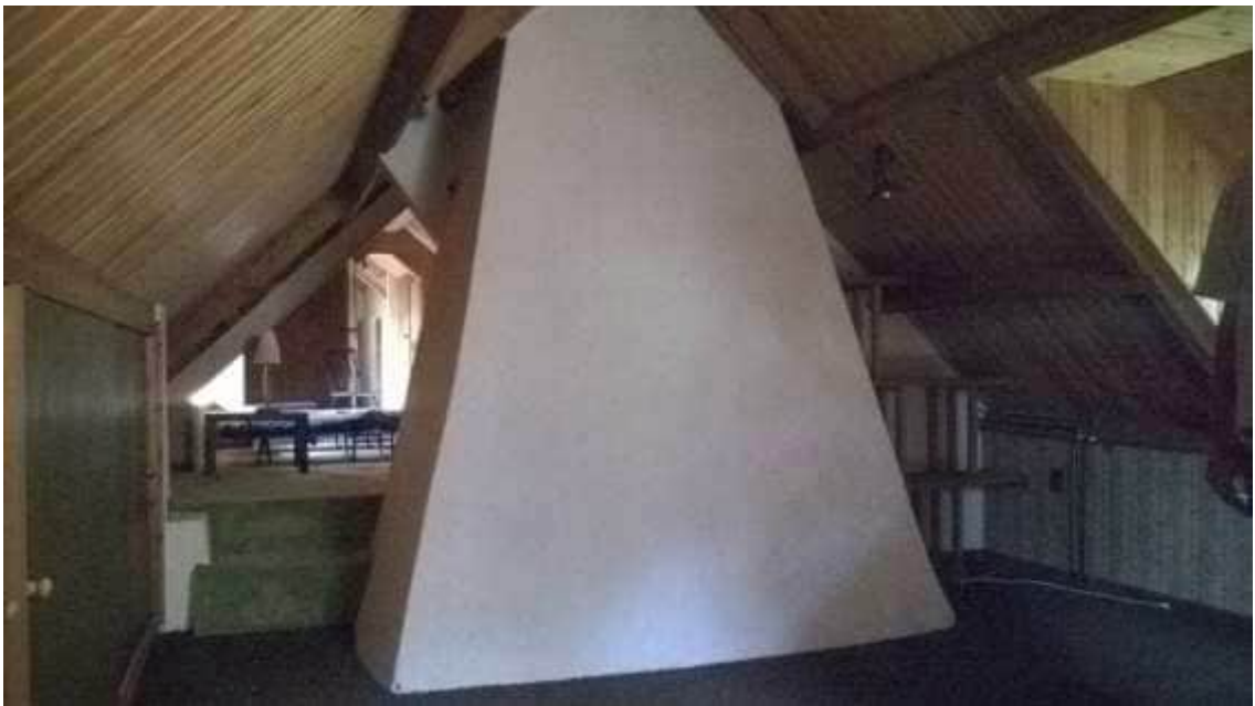
Het oorspronkelijke gemetselde rookkanaal boven de voormalige brandmuur.
