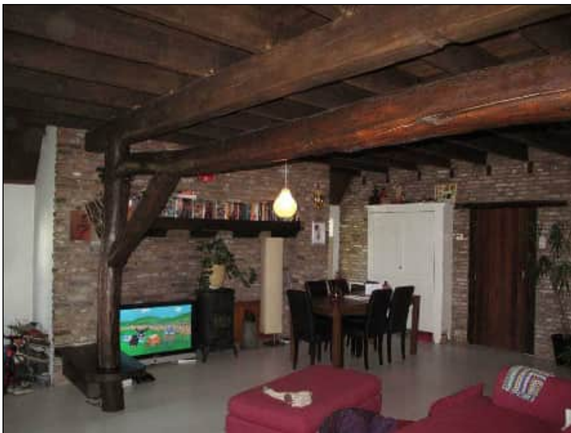
De dichtgemetselde toegang tot de deel in de rechter zijgevel van de woonkamer (zie hulpkaart 1963).
