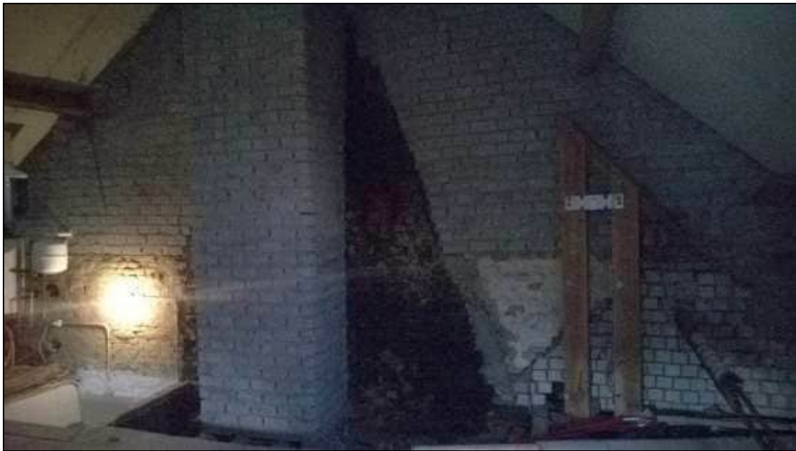
Zicht vanaf de verdieping van het voorhuis op de brandmuur, met de duidelijk herkenbare aftekening van het rookkanaal.
