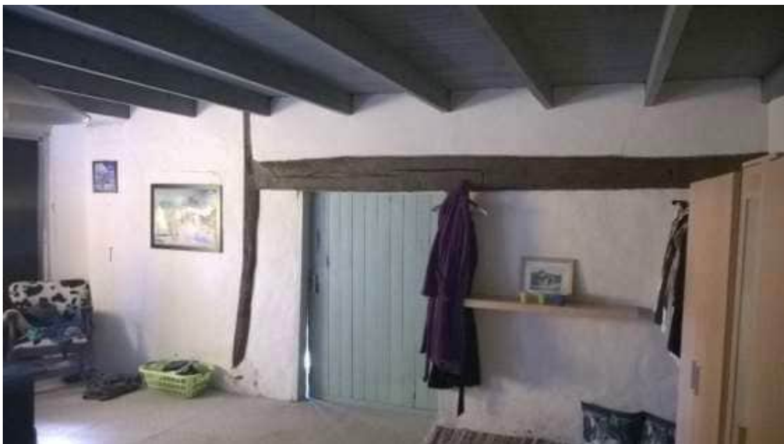
Het tweede ingemetselde etagegebint, gezien vanuit de tweede travee van het achterhuis (richting achtergevel).
