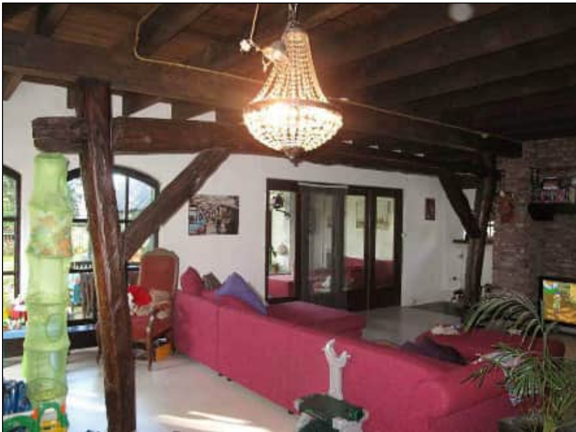
Het ankerbalkgebint in de huidige woonkamer.
