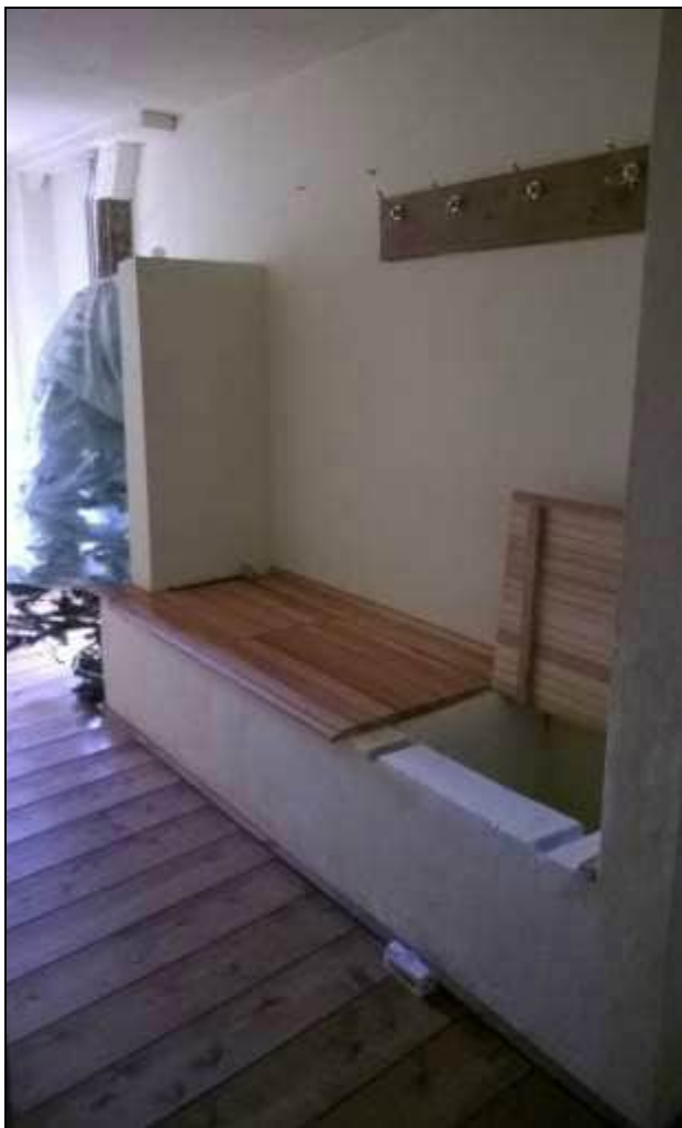
Gemetselde bakken in de schuur.
