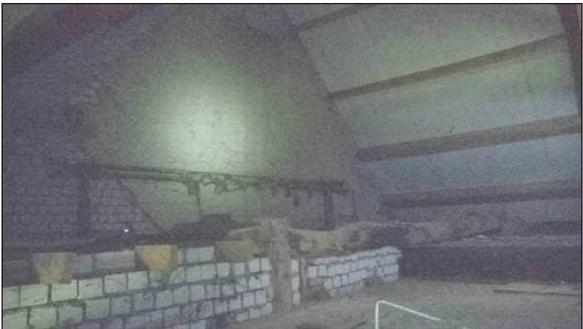
Zolder boven het achterhuis, richting de brandmuur, met op de voorgrond de afgezaagde bovenzijde van het voorste etagegebint.
