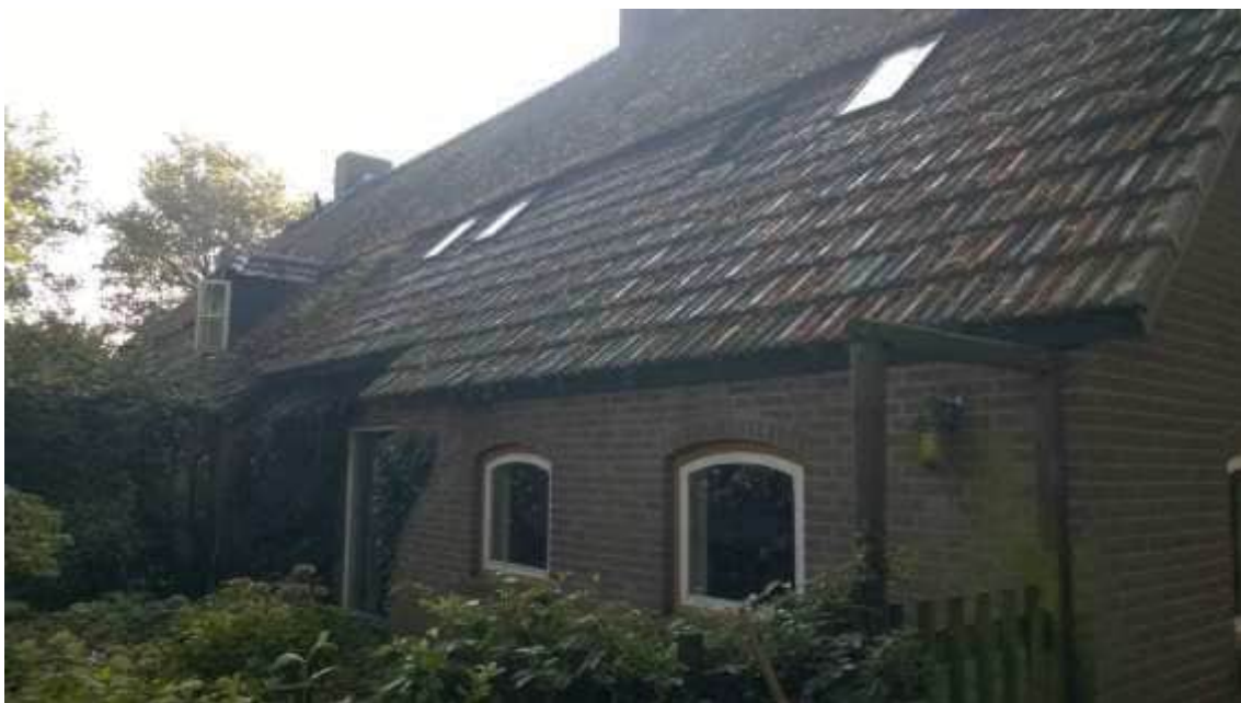
Overzicht van de vernieuwde rechter zijgevel van het achterhuis.
