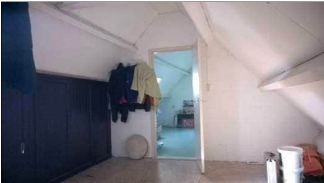
De geheel vernieuwde dakconstructie, hier boven het achterhuis.
