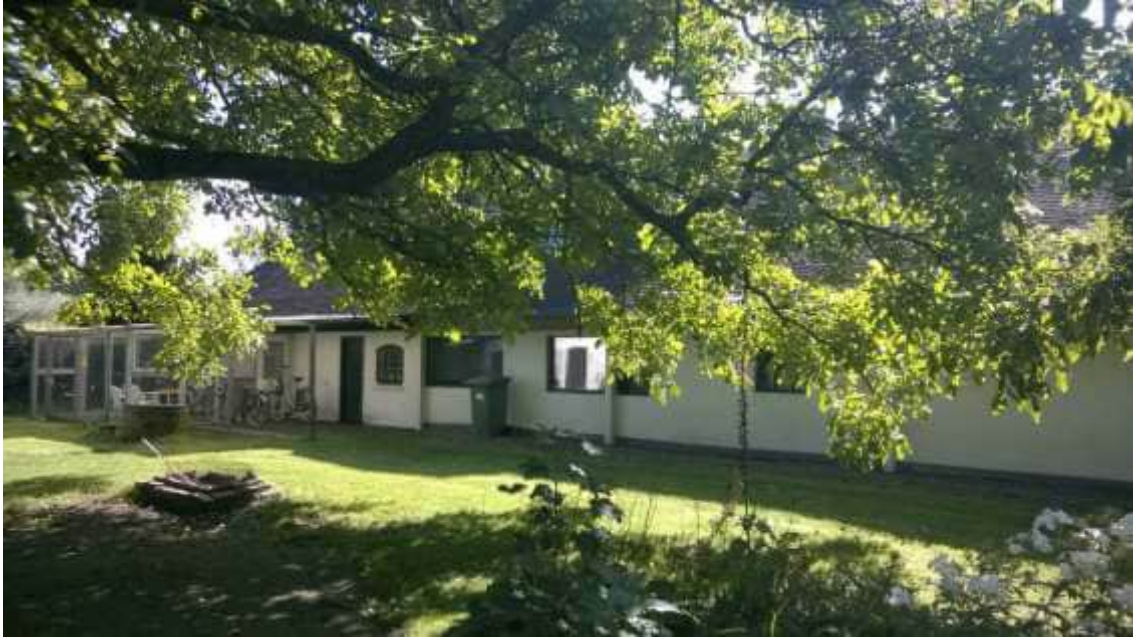
De rechter zijgevel, met langs de gevel geplaatste stalen spantbenen.
