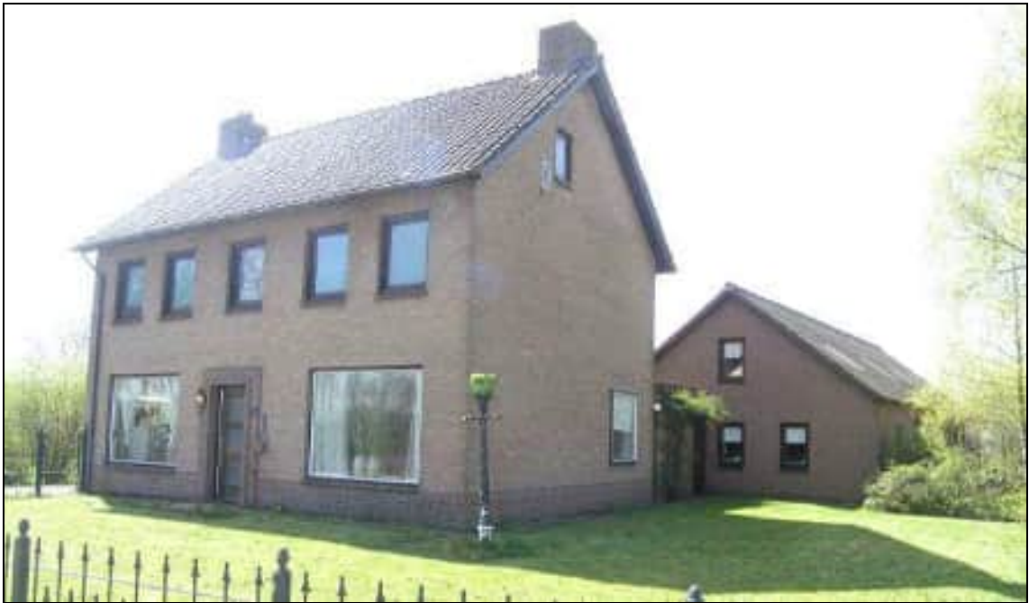
Tweelaags woonhuis onder een met opnieuw verbeterde holle pannen gedekt zadeldak, vermoedelijk XXc. Rechtsachter de woning een jongere schuur.
