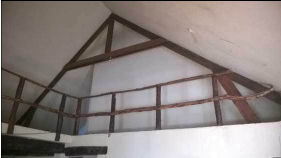
Eén van de A-spanten van de schuur.
