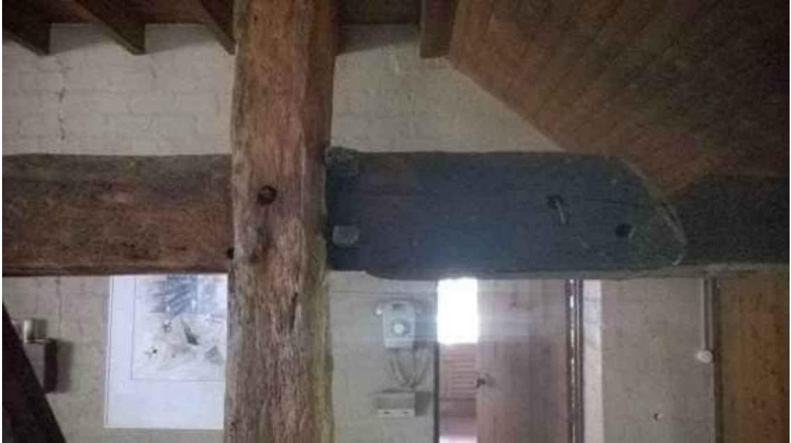
Detail van het voorste ankerbalkgebint. De toognagelgaten in het uiteinde van de ver doorstekende ankerbalk markeren de plaats van de oorspronkelijke aansluiting met een gebintstijl. Vermoedelijk dateert deze aanpassing uit 1907.
