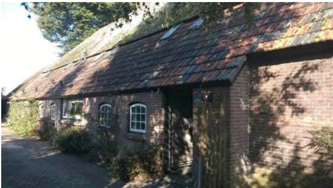
Overzicht van de vernieuwde linker zijgevel van het achterhuis.
