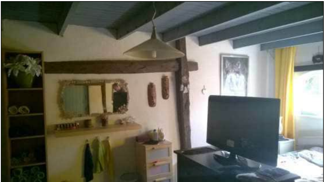
Het in een wand opgenomen voorste etagegebint, gezien vanuit de tweede travee van het achterhuis (richting voorgevel).
