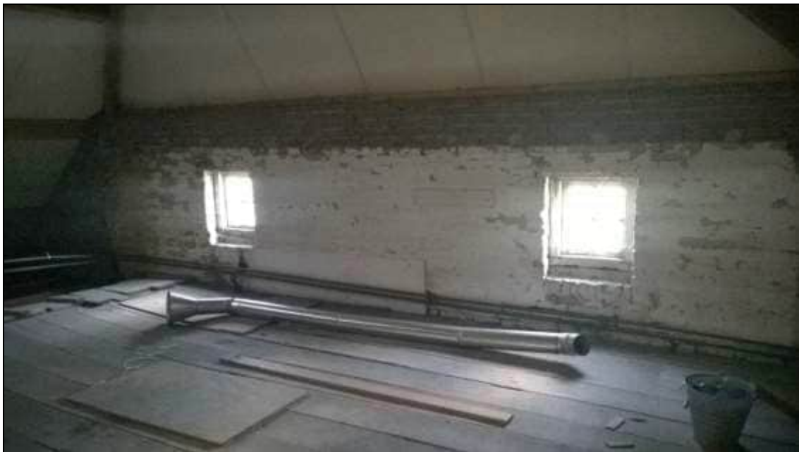
Binnenzijde van de voorgevel, welke hier met zeer zachte, lichtrode stenen is opgebouwd.
