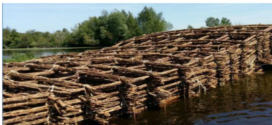
Afbeelding 6 Kleilaag versterkt met zinkstukken en stortsteen aan waterzijde en kruin.
