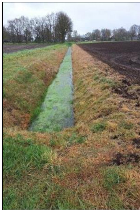
Afbeelding 12: Bespuiting over het talud
