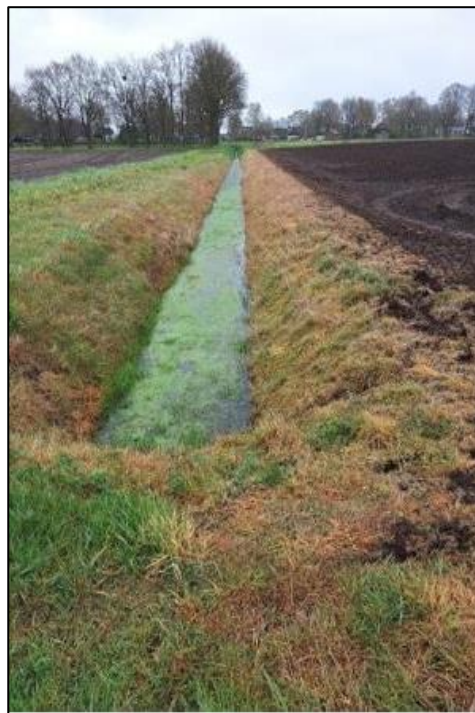
Afbeelding 12: Bespuiting over het talud
