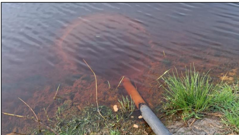
Afbeelding 7: Lozing ijzerrijk water vanuit een bronnering
