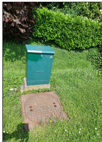
Afbeelding 13: Drukriool put (aansluiting op persriool)
