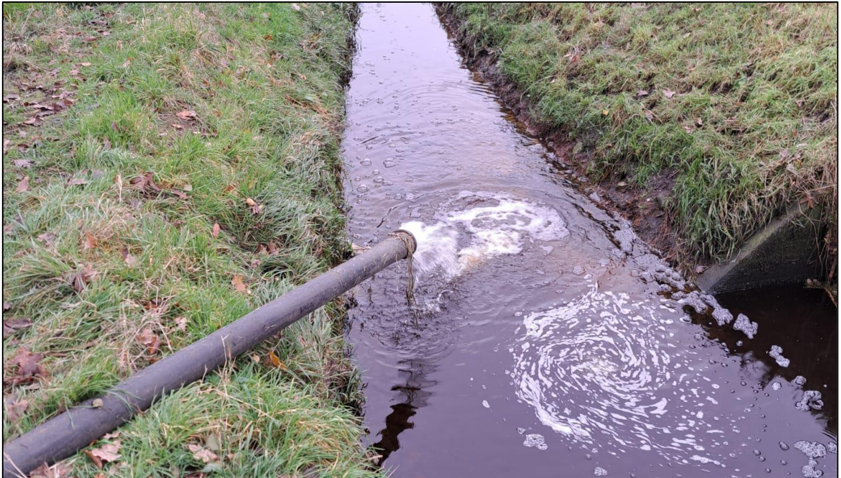
Afbeelding 17: Lozing vanuit een bronnering
