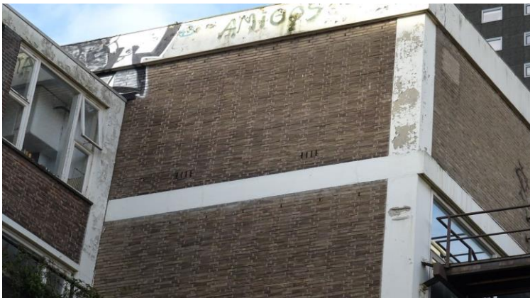
Gevel met open stootvoegen en ventilatieroosters. Foto: K.J. van Veen | Ecoresult B.V.
