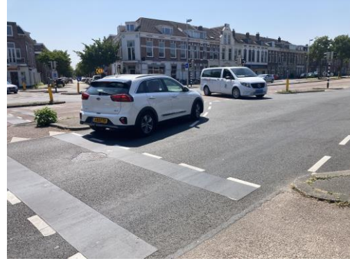
Afbeelding 12: Fietsoversteek over de Vleutenseweg is voorzien van kanalisatiestrepen
