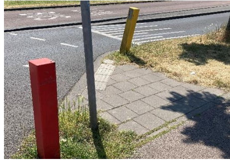
Afbeelding 21: Schuine afloop opstelruimte voetgangersoversteek
