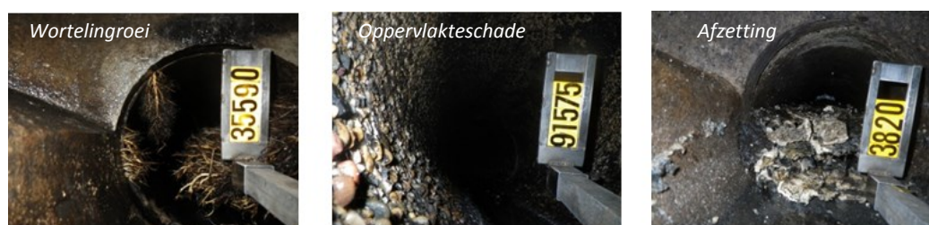
Figuur 18: Foto's globale inspectie
