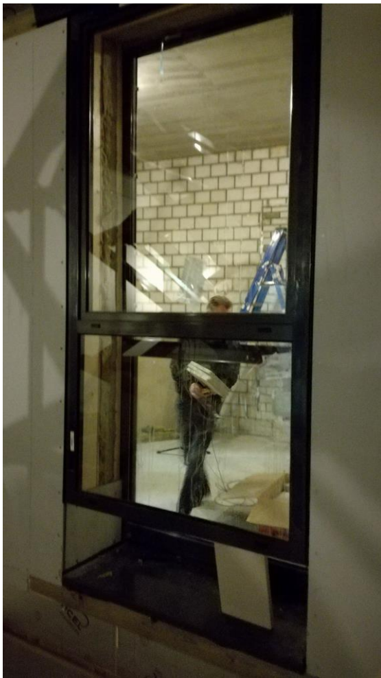
Kozijn buitengevel (meetkamer 3)
