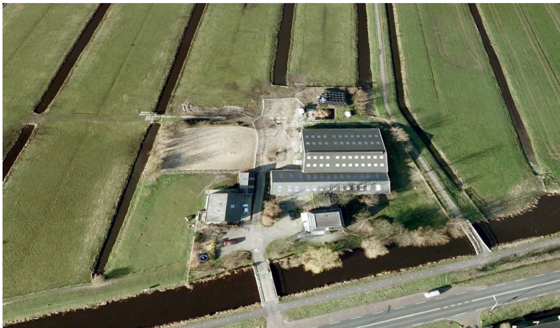
Huidige situatie plangebied (Bron: Google Earth)
