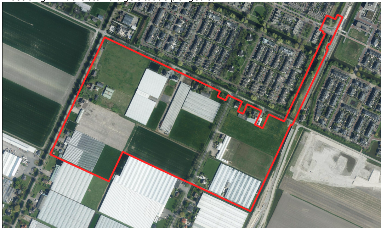
Afbeelding 2: Luchtfoto huidige situatie plangebied
