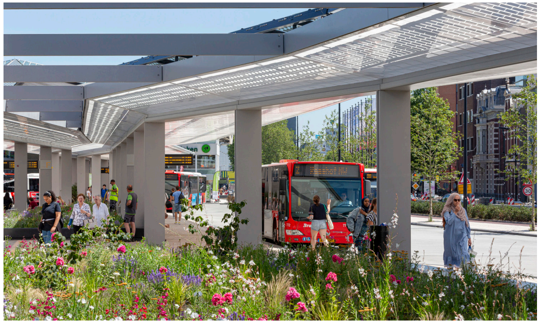
Referentie bushalte met comfort voor de reiziger, station Tilburg. Foto: Cepezed, Lucas van der Wee
