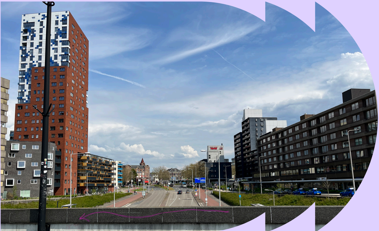
Tunnelweg in de huidige situatie
