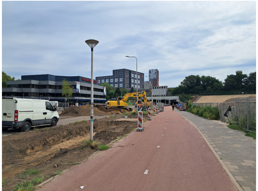
Werkzaamheden aan de Tunnelweg en voormalig UWV
