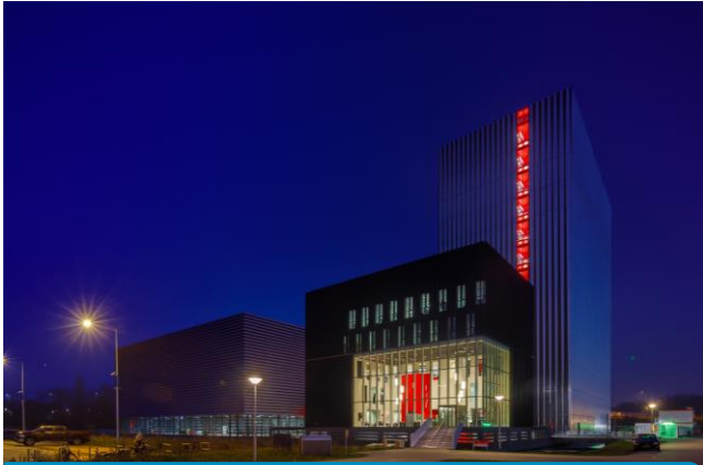
Elektrificatie bedrijven en industrie
