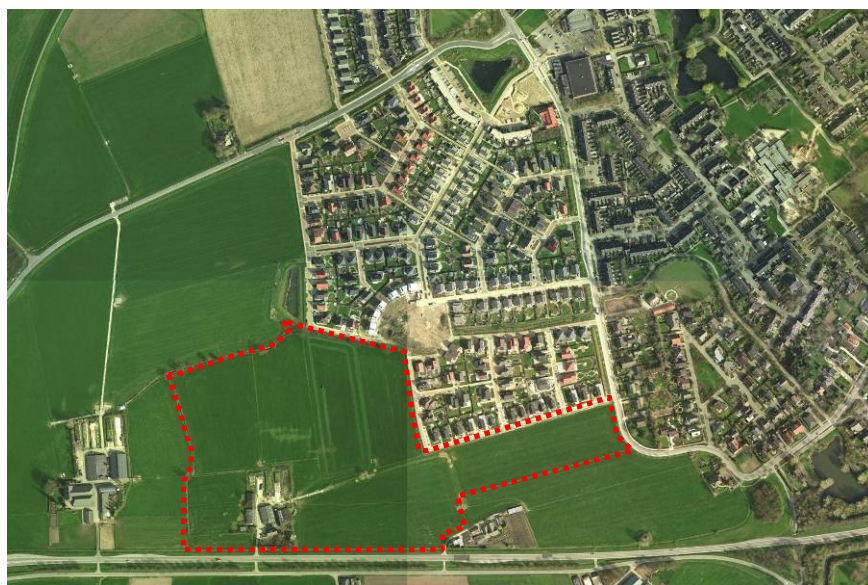
Luchtfoto bestaande situatie
