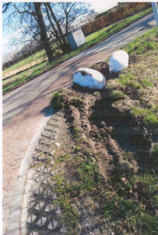
Kapot gereden bermkanten in Oude Bredasepostbaan
