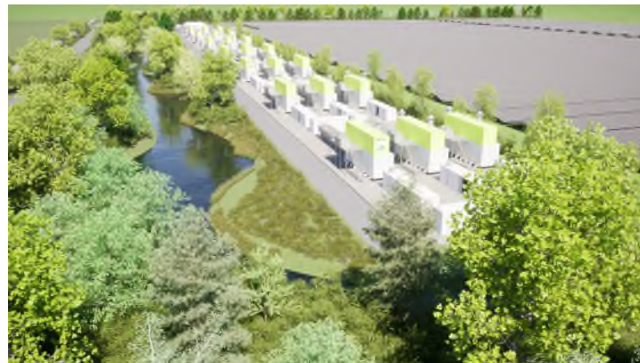
Impressie totale installatie
