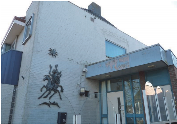
Fig. 5. Detail voorkant van het pand, aan de noordzijde. Er zijn geen open stootvoegen of andere invliegmogelijkheden voor vleermuizen.
