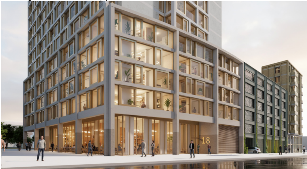
Afbeelding 5: Gevelaanzicht van Reykjavikstraat
